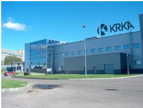
Slika 2.2. Visoko regalno skladišče v podjetju KRKA z 12 000 mesti
