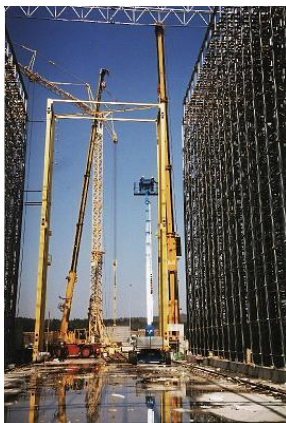
Slika 2.14. Gradnja visoko (80 m) regalnega skladišča
